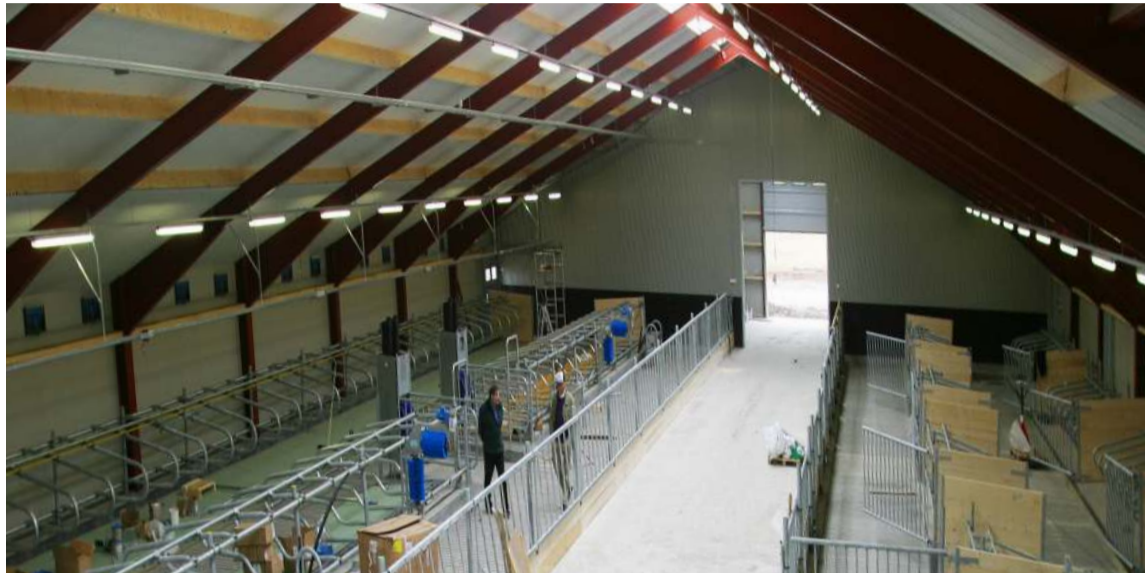
Nútímalegt fjós á lokastigum byggingar.
